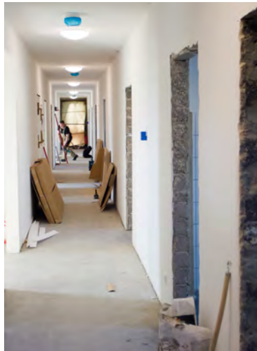
Inzwischen sind auch die Türen montiert.
