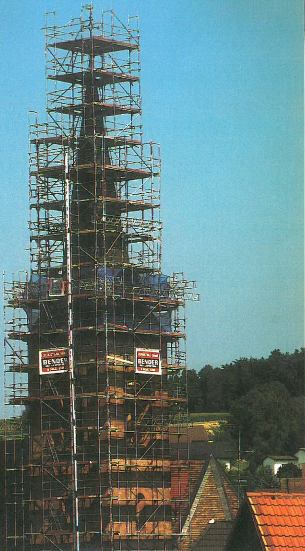
Der eingerüstete Turm vor Abbau des alten Turmhelmes im August 1997
