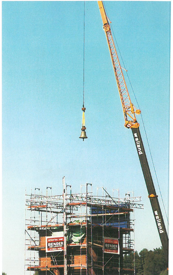
Die Glocken werden in den neuen Glockenstuhl eingebracht.
