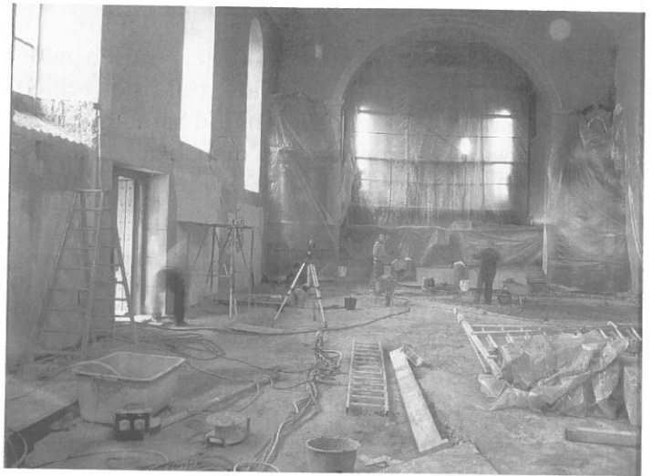
Der Barockteil vor Einbau des Bodenbelages aus Marmor im März 2001
