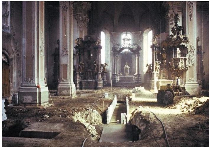
Abb. 52: Der Einbau der neuen Heizung, 1978
