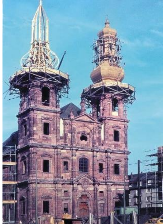
Abb. 50: Wiederherstellung der Türme von St. Peter 1961
