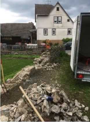
Foto: Abtransport der Natursteinmauer
