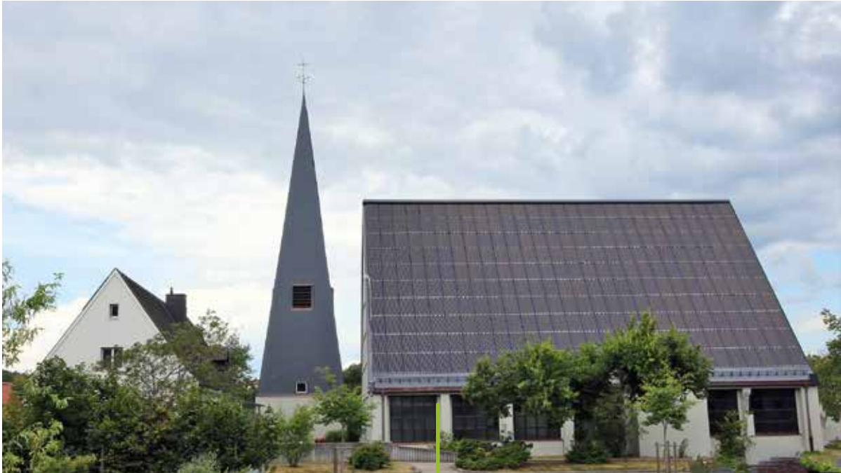
Das Dach der Pfarrkirche St. Wunibald, Georgensmünd wurde vollständig mit einer Solaranlage eingedeckt.
