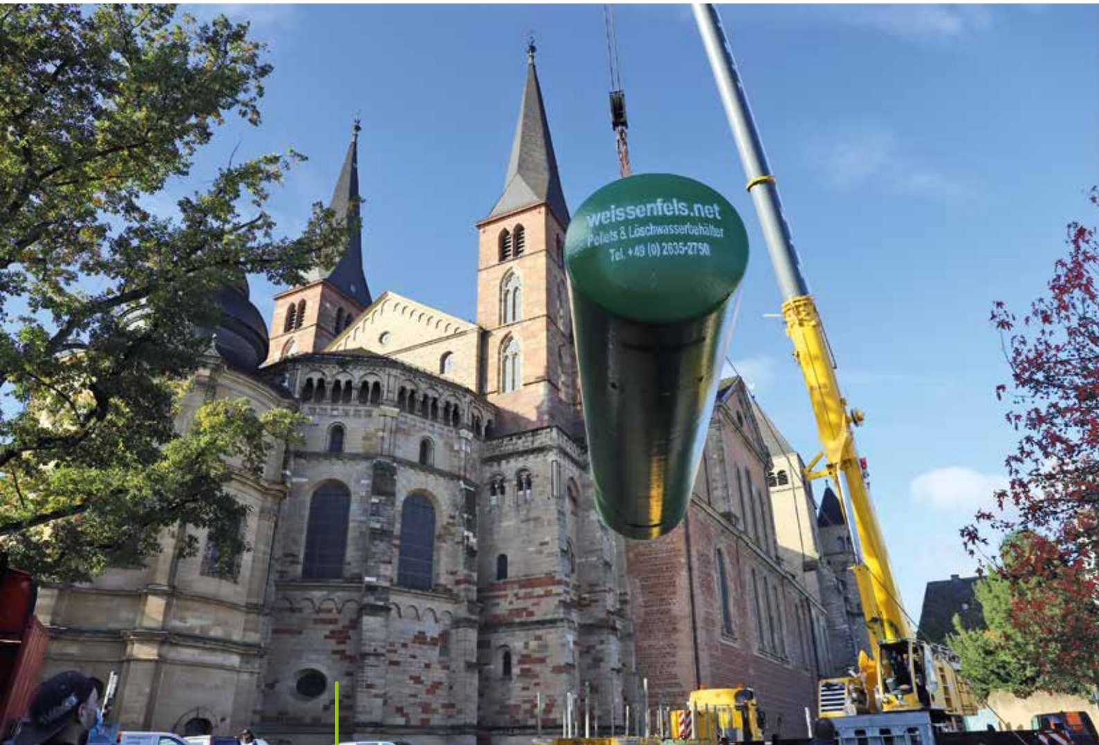
Der Pellet-Tank für die neue Pellet-Heizung im Museum am Dom in Trier wird angeliefert. Es ist das erste große Museum in Deutschland, das mit regionalem Holz beheizt wird.
