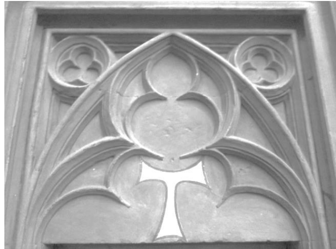
Antoniterkreuz im gotischen Maßwerk über der ehemaligen Eingangstür der Kirche
